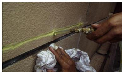
Gambar 3 *Retrofitting* dengan metode *injection*
