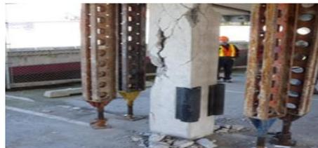
Gambar 1 Retrofitting dengan Metode Patching
