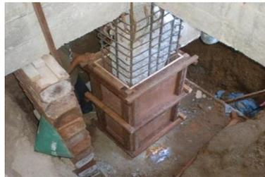
Gambar 2. *Retrofitting* dengan metode *grouting*
