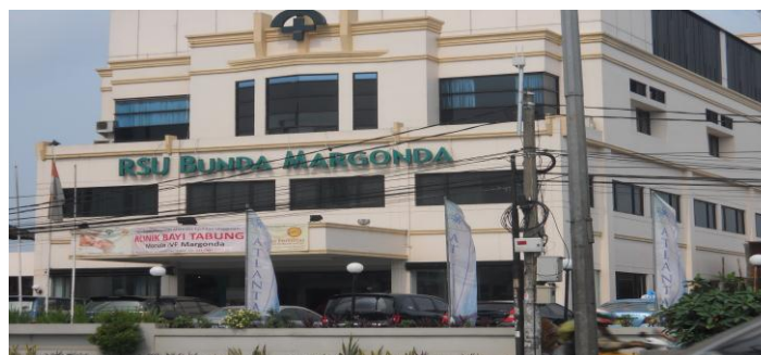
Gambar 2. Kondisi Tampak Depan RSU Bunda Margonda Depok
