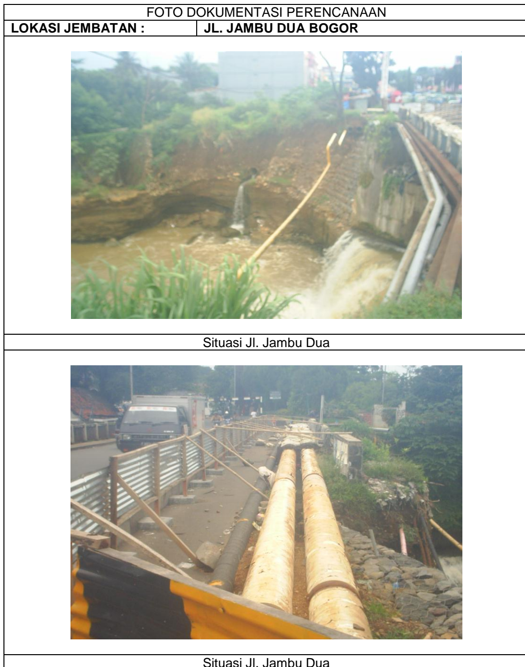
Penampang perpipaan dengan rangka disisi jembatan
