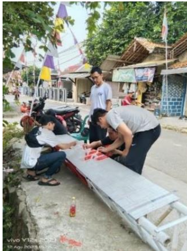
Gambar 6. Proses Pembuatan Gapura Desa Bojong Sempu
