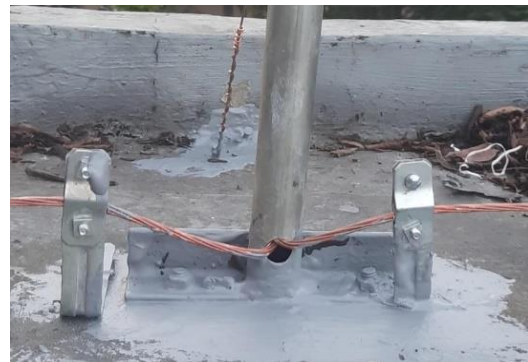
Gambar 3.6 Bentuk fisis pemasangan clamp pada down conductor
