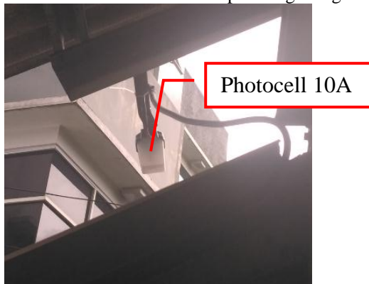
Gambar 12 Penerapan Photocell pada atap
