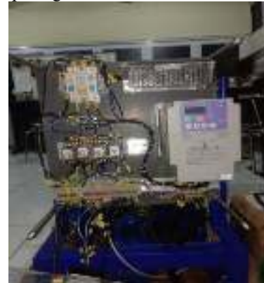
Gambar 3.6 Pemasangan dan pengawatan sejumlah komponen pada subsistem pengontrol bagian dalam panel
