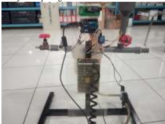
Gambar 3.1 sistem monitoring kelembaban udara otomatis berbasis Iot pada tekanan kompresor
