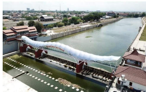
Gambar 2. Tampungan kolam retensi di hulu Bendung Karet Tirtonadi
