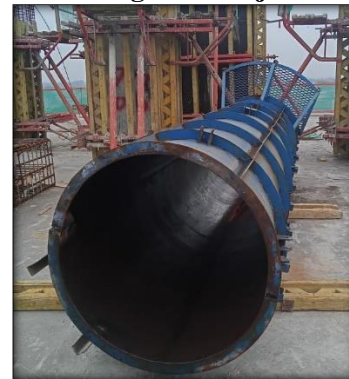
Gambar 5 Pelepasan Bekisting Jenis Pelat Baja
