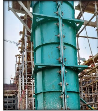
Gambar 4 Pemasangan Bekisting Jenis Pelat Baja
