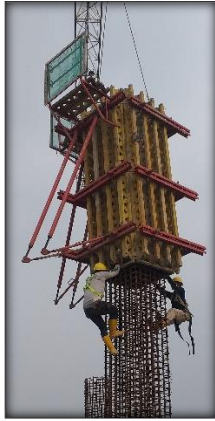
Gambar 2 Pemasangan Bekisting Jenis Konvensional
