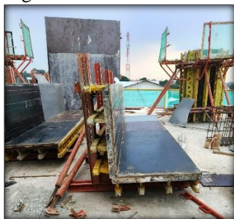
Gambar 3 Pelepasan Bekisting Jenis Konvensional
