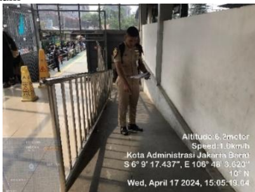
Gambar 9. Observasi Fasilitas Ram Stasiun Duri Stasiun Duri mempunyai 2 pintu masuk, yaitu pintu bagian barat dan pintu bagian timur. Hasil observasi di lapangan hanya di pintu bagian barat saja yang terdapat ram. Kelandaian maupun kemiringan ram yang ada
