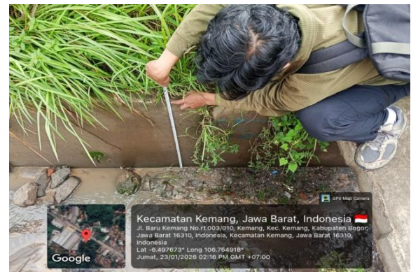
Gambar 5 sedimentasi pada drainase
