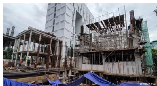
Gambar 5. Tampak pekerjaan struktur
