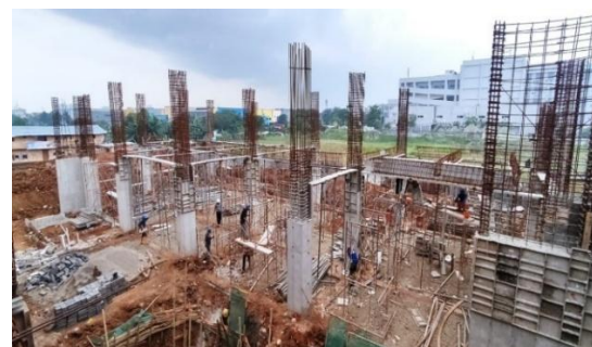
Gambar 4 Pekerjaan Pemasangan Bekisting
