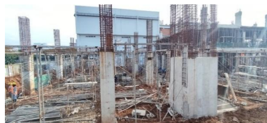
Gambar 3 Pekerjaan Pengecoran kolom
