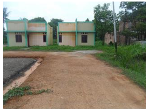
b) Situasi jalan lingkungan dan drainase
