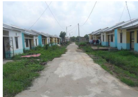
b) Situasi jalan lingkungan dan drainase
